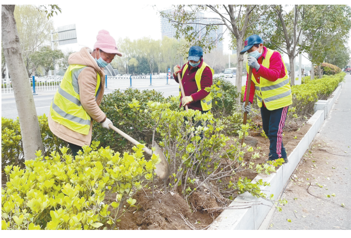
春回大地万物苏,植树添绿正当时。3月21日上午,在市城乡一体化示范区周口大道与府汇街交汇处,园林绿化工人与挖掘机协同作业,给该路段绿化带进行绿植补给。 记者 刘昂 实习生 鲁文意 摄
