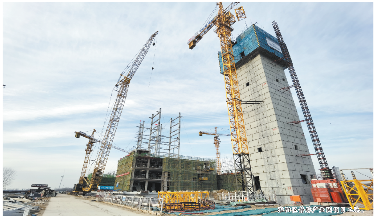
淮阳区塑料制品产业园项目工地。
