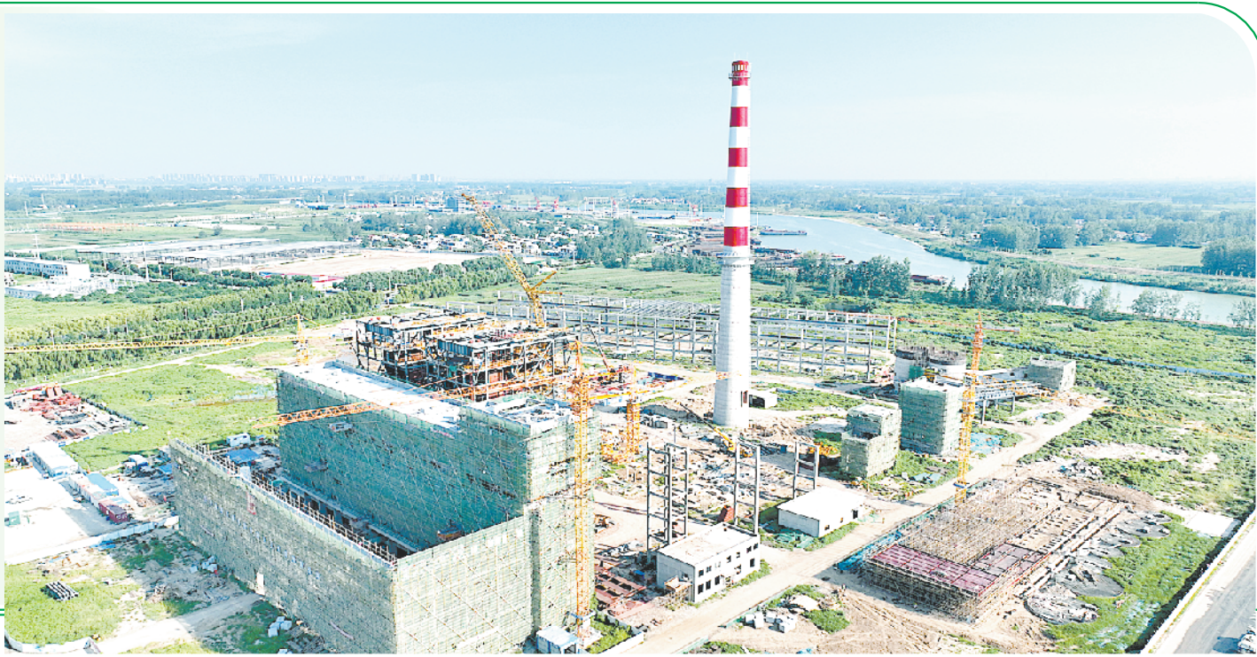
周口港区大力推进项目建设,全力服务企业生产,减少疫情对项目建设和企业正常生产经营的影响。图为周口港口综合物流园区热电联产项目主体工程初现雏形。 记者 宋风摄
