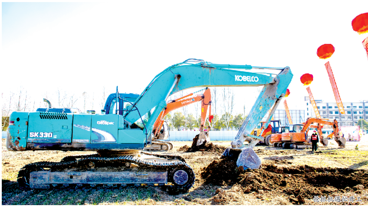
抢抓机遇搞施工
