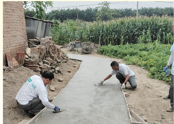
近日,县工商联驻箕子台街道唐宋岗社区工作队走访群众时,发现部分群众家门前的道路坑洼不平,严重影响群众出行,便积极组织爱心人士筹集资金硬化道路,切实帮助群众解决出行难问题,受到群众一致好评。图为工人对道路进行硬化。
