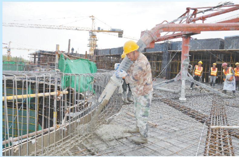
混凝土浇筑(资料图)
