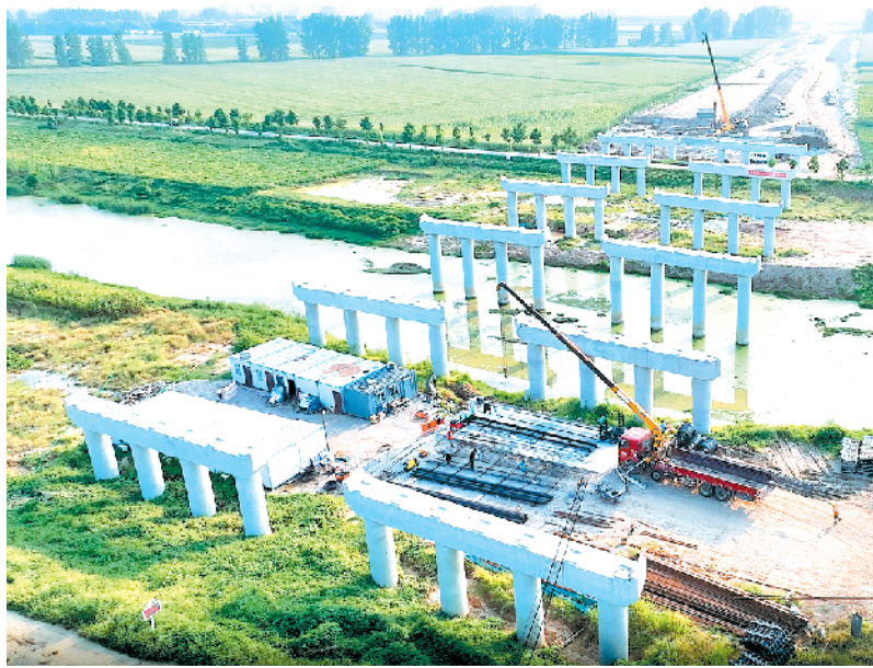
中心城区平安大道东延工程施工现场。段九君 摄
