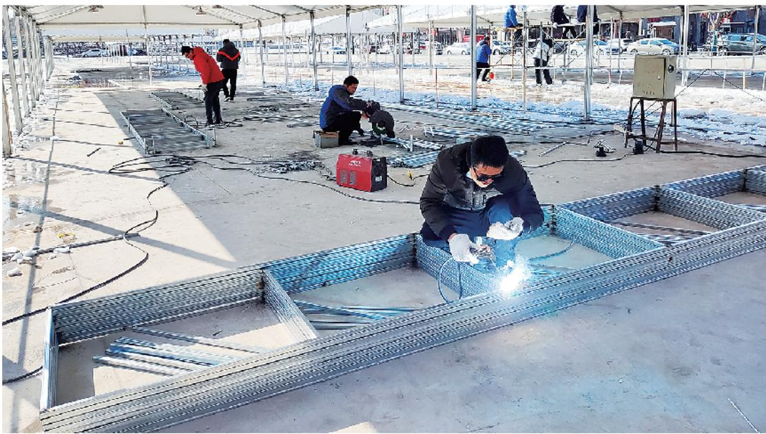
展区大篷内工人正在进行水电安装、焊接等扫尾工作。
